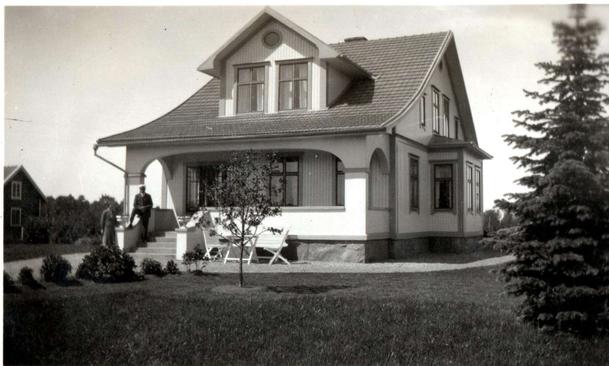
Huset Åkerhill i Slutarp
